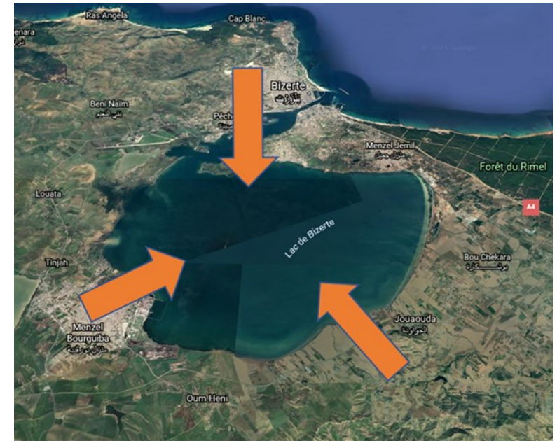
Effluents et dégradation physico-chimique des eaux du lac
