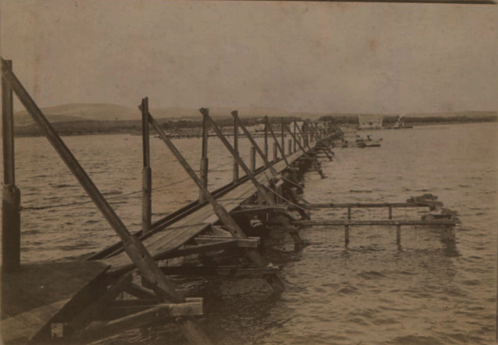
Bordigue de Ras El Ouzir (1890-1906). Muraille Est de la bordigue. En rupture avec une tradition ancestrale, le barrage est désormais constituée de pièces métalliques. Au premier plan, une chambre de capture. Source: Collection privée.
